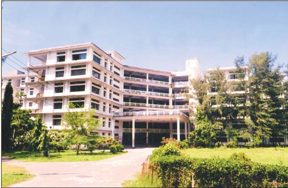
নবনির্মিত ২টি অ্যাকাডেমিক ভবনের ১টি, চট্টগ্রাম বিশ্ববিদ্যালয়
