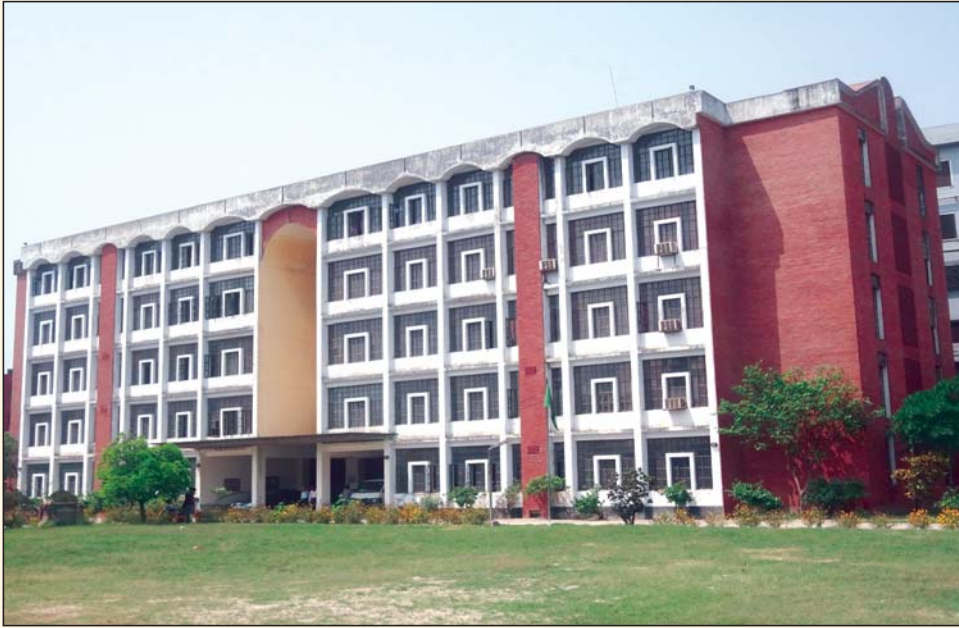
নবনির্মিত বি.এম.টি.টি.আই. প্রশাসনিক ভবন
