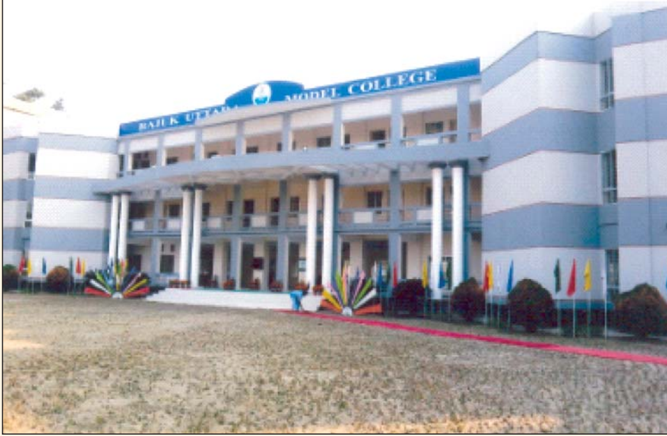
নবনির্মিত অ্যাকাডেমিক ভবন, রাজউক উত্তরা মডেল কলেজ, ঢাকা
